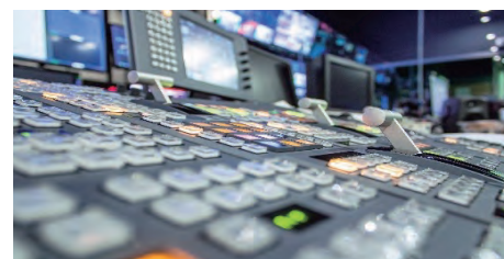
サブコントロールルーム
